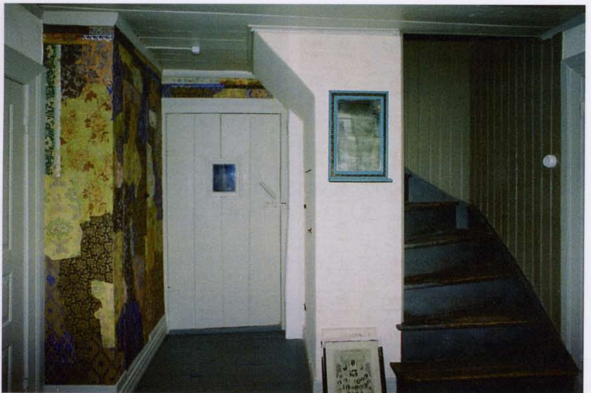
Rum 101 efter avslutad renovering, 2006-10-26. På det väggfast skåpet till vänster i bild påträffades flera äldre tapetlager. Väggytan kompletterades med andra tapetrester från byggnaden, istället för att tapetseras med nya tapeter. Neg.nr: 06/122:19A. Foto: Ulf Larsson.
