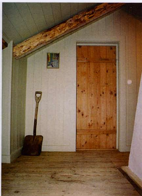
Samma parti av vindsvåningen som på bilden till vänster efter avslutad renovering, 2006-10-26. Neg.nr: 06/123:15. Foto: Ulf Larsson.
