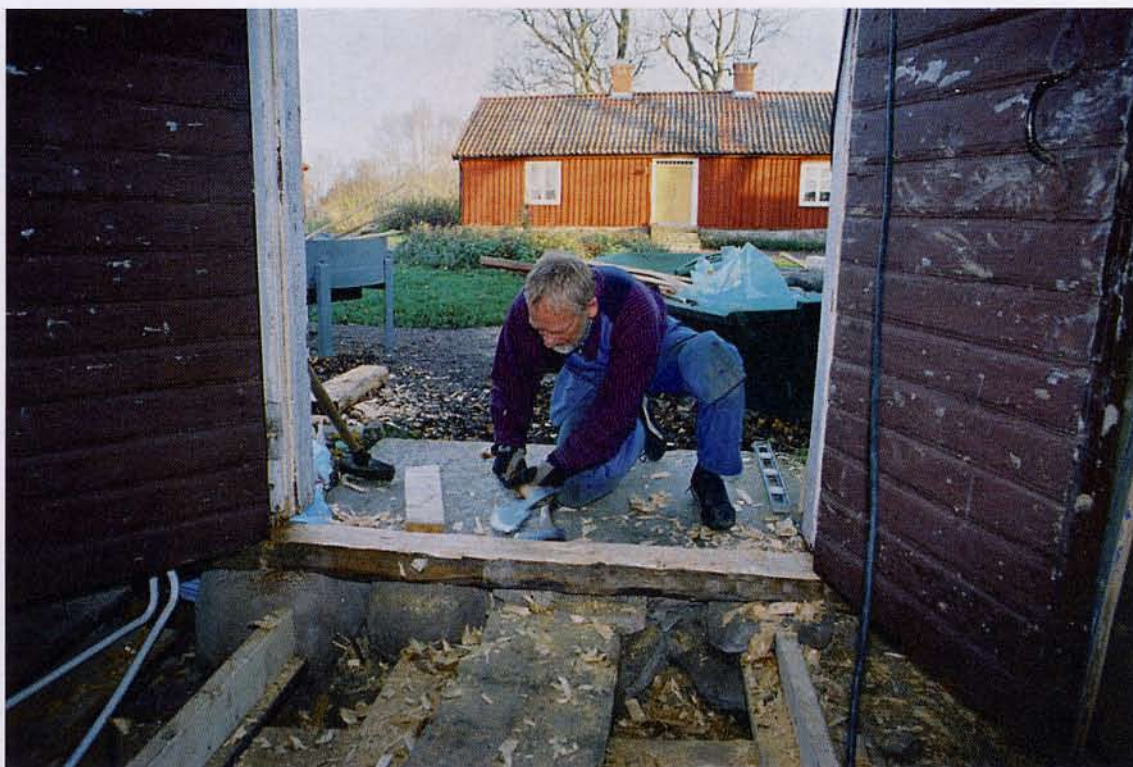
Olle Dagobert skarvar den rötskade syllen vid entrén med nytt virke, 2005-11-09. I bakgrunden syns den norra flygelbyggnaden på Torp. Neg.nr: 05/169:0A. Foto: Ulf Larsson.
