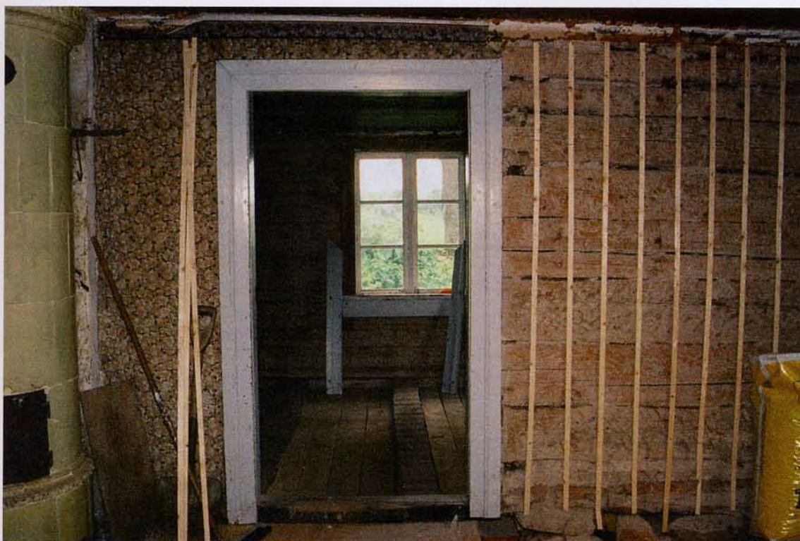
Montering av putsbärare för väggarnas lerklining i form av smala träribbor och kycklingnät har påbörjats i rum 102, 2005-09-07. Notera partiet med ursprungliga tapellager på lerklining till vänster om dörröppningen. Neg.nr: 05/107:13. Foto: Ulf Larsson.
