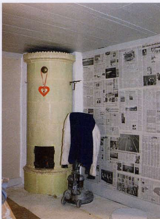
De lerklinade väggarna i rum 106 har klätts med tidningspapper inför tapetsering, 2006-01-27. Neg.nr: 06/54:26A. Foto: Ulf Larsson.
