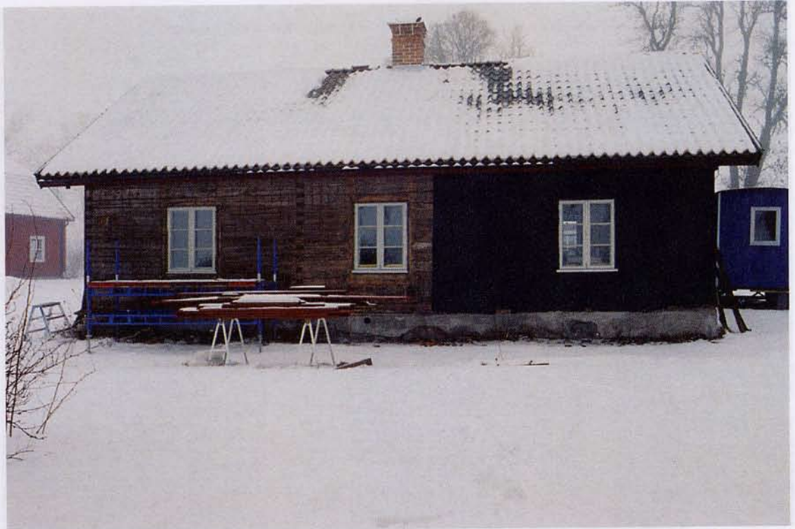
Södra flygelbyggnaden i samband med renovering av södra fasaden, 2006-02-23. Den del av fasaden som inte har invändigt lerklinade väggar har, utöver drevning med lindrev, försetts med förhådningspapp. Neg.nr: 06/61:34A. Foto: Ulf Larsson.
