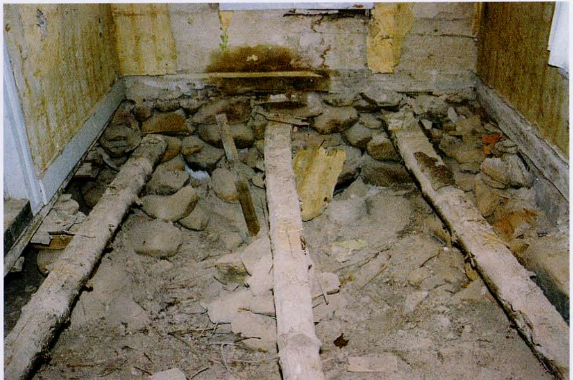
Bjälklaget i rum 105, 2005-05-18. Bärlinorna utgjordes av obarkade granstockar och istället för bjälkar låg kraftiga plank (borttagna vid fotografieringstillfället). Neg.nr: 05/84:14A. Foto: Ulf Larsson.
