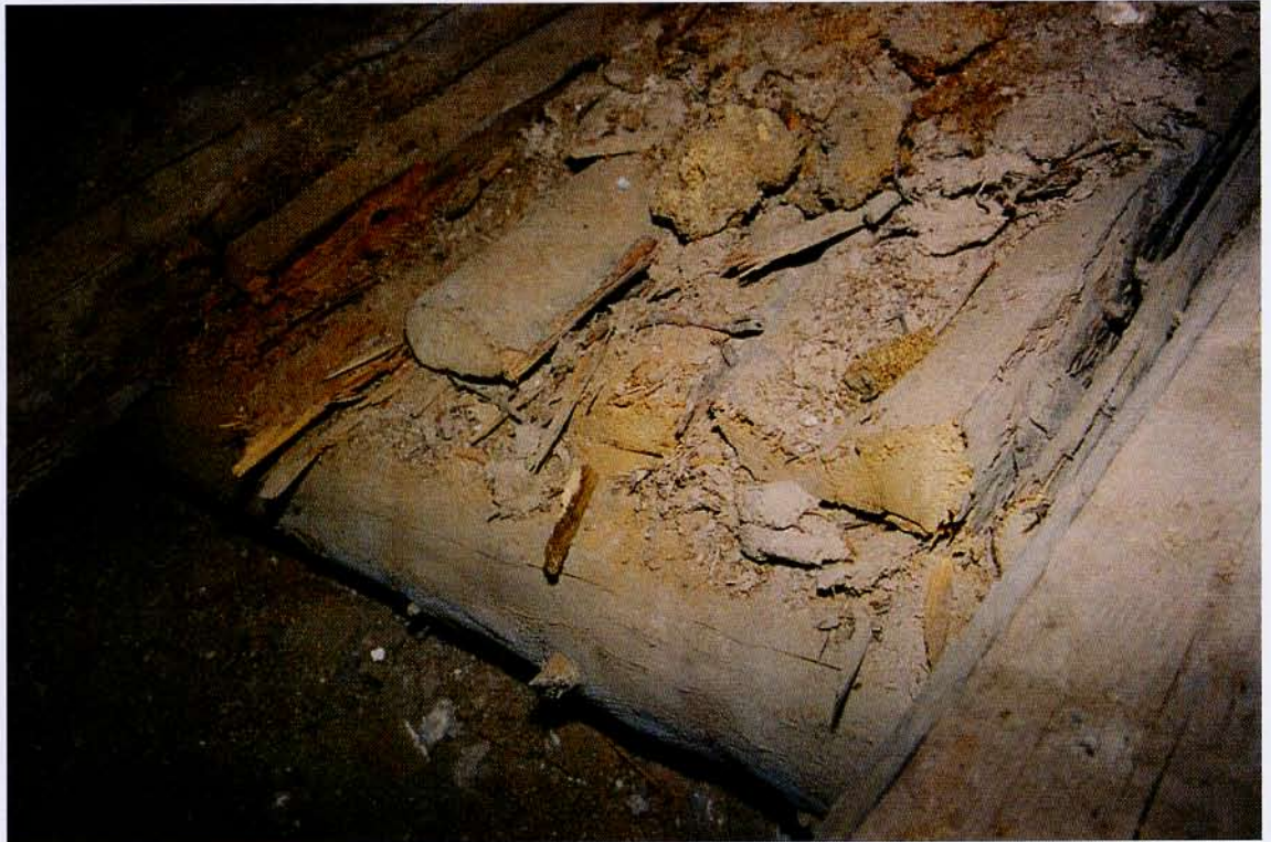
Bjälklaget i rum 103, 2005-05-02. Blindbotten utgjordes i detta rum till stor del av spräckta slakor och bjälklagsfyllningen av lera och träspån med inslag av enris. Neg.nr: 05/73:4A. Foto: Ulf Larsson.
