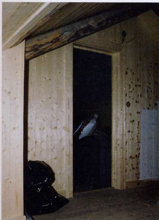
Vindsvåningens mittparti, 2005-12-18. Väggen mot östra kammaren har klänts med slätpanel. Neg.nr: 05/178:3A. Foto: Ulf Larsson.
