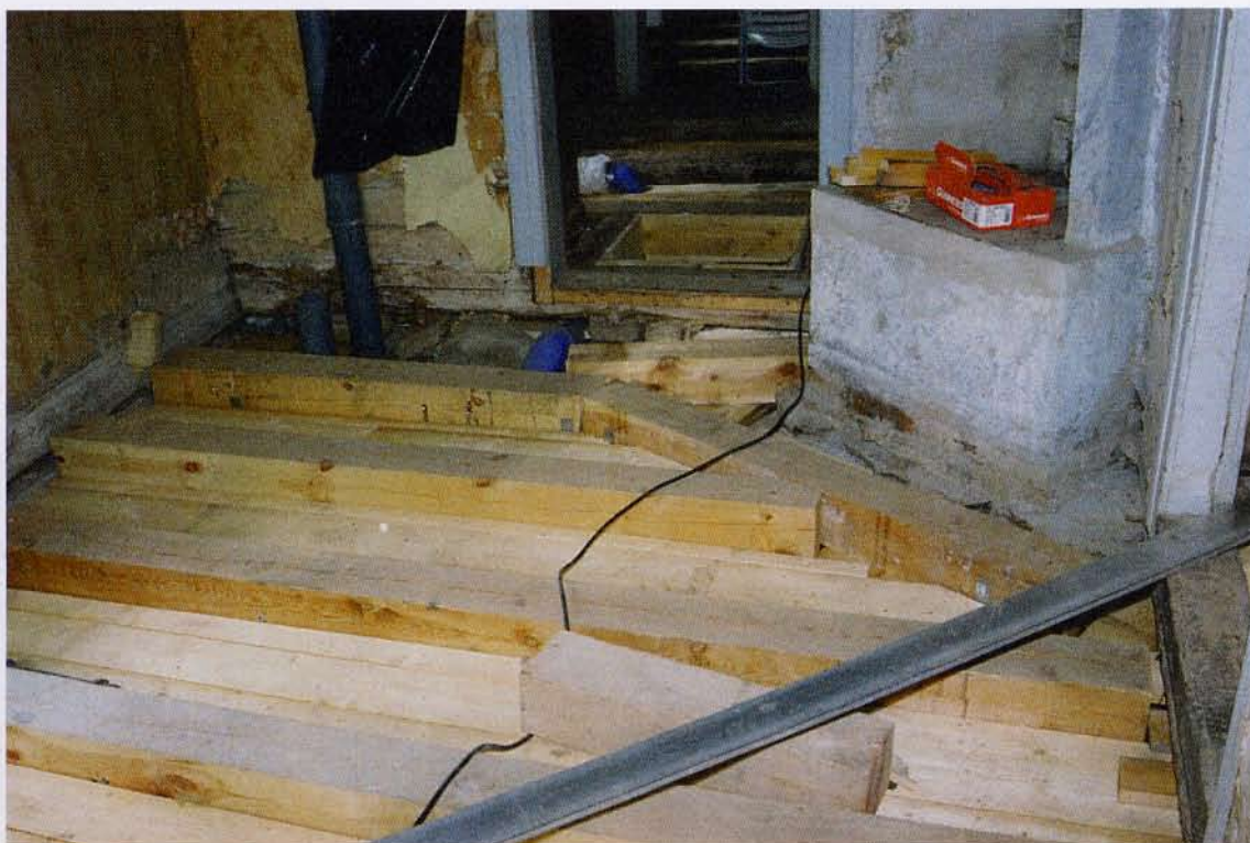
Ett nytt bjälklag har byggts upp i rum 105, 2005-08-26. I bakgrunden skimtar köket, där en lucka till källarutrymmet anordnats i golvet. Neg.nr: 05/103:2A. Foto: Ulf Larsson.
