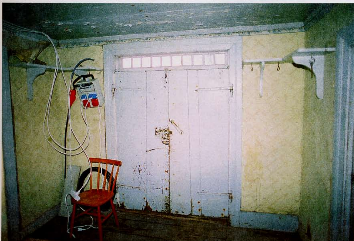
Rum 101, Förstuga. Vy mot norra väggen. I bildens mitt ytterdörrarnas insidor. Neg.nr 03/468:25. Foto: Lisa Molander
