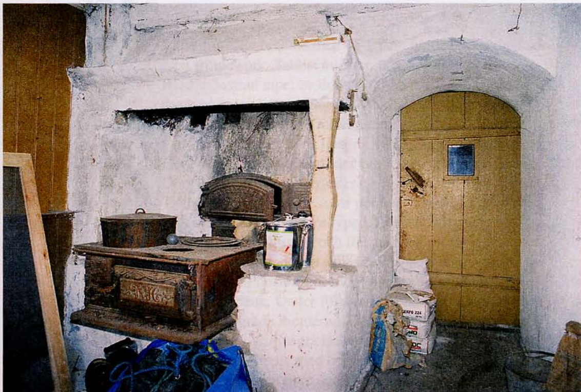
Rum 104, Kök. Ugnskomplex med bakugn, järnspis och murad spiskupa. Till höger i bild syns dörren till förstugan. Lägga märke till valvslagningen mot förstugan. Neg.nr 03/495:25. Foto: Ulf Larsson
