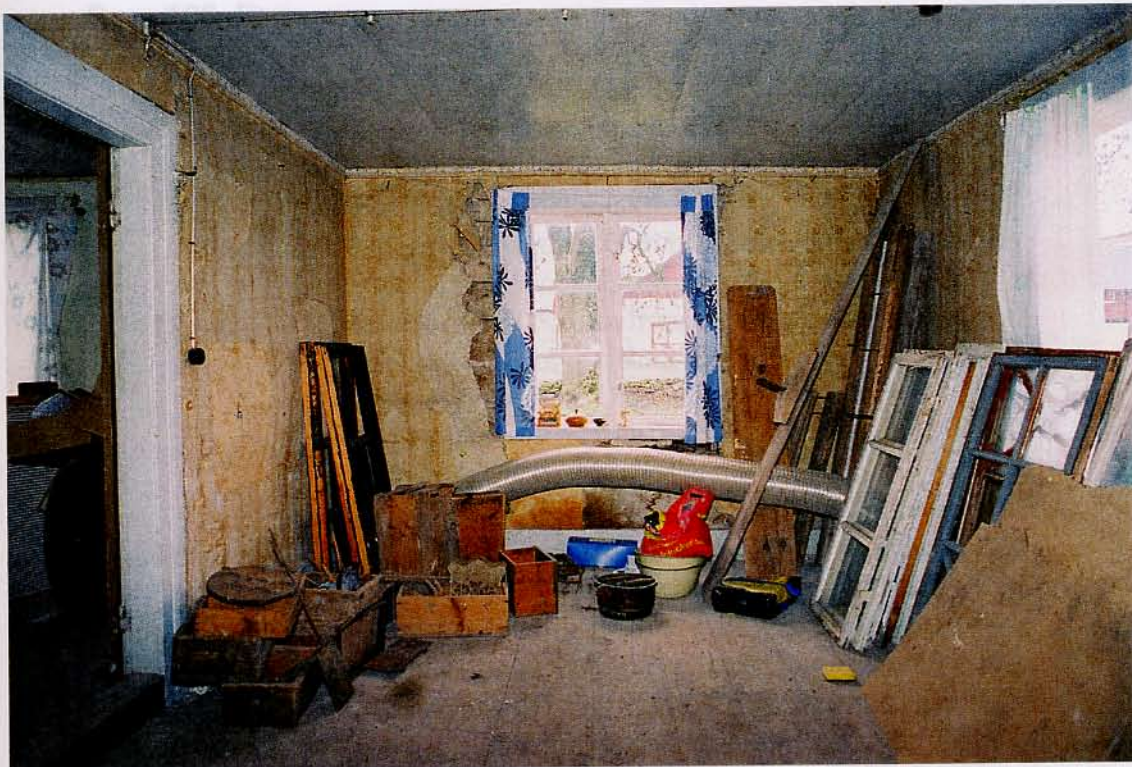
Rum 105. Vy mot östra väggen. Neg.nr 03/495:26. Foto: Ulf Larsson
