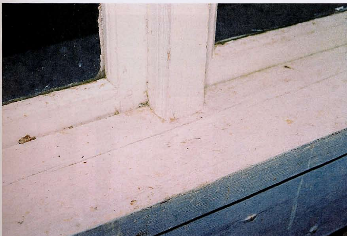
Rum 102. Detalj av profilerad mittpost och fönsterbänk. Neg.nr 03/495:5. Foto: Ulf Larsson
