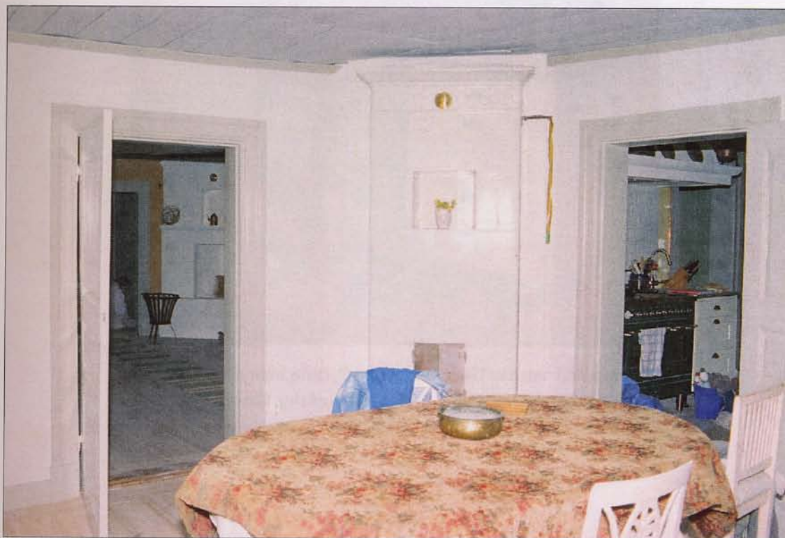
Matrummet har färdigställt med den renoverade kakelugnen i centrum av bilden, här skimtar även den nyuppförda rörspisen till vänster och kökets spiskomplex till höger. Väggarna har tapetserats med "alnstora" pappbitar och målats vita för att senare dekormålas. 2003-09-25. Neg. nr 03/362:9.
