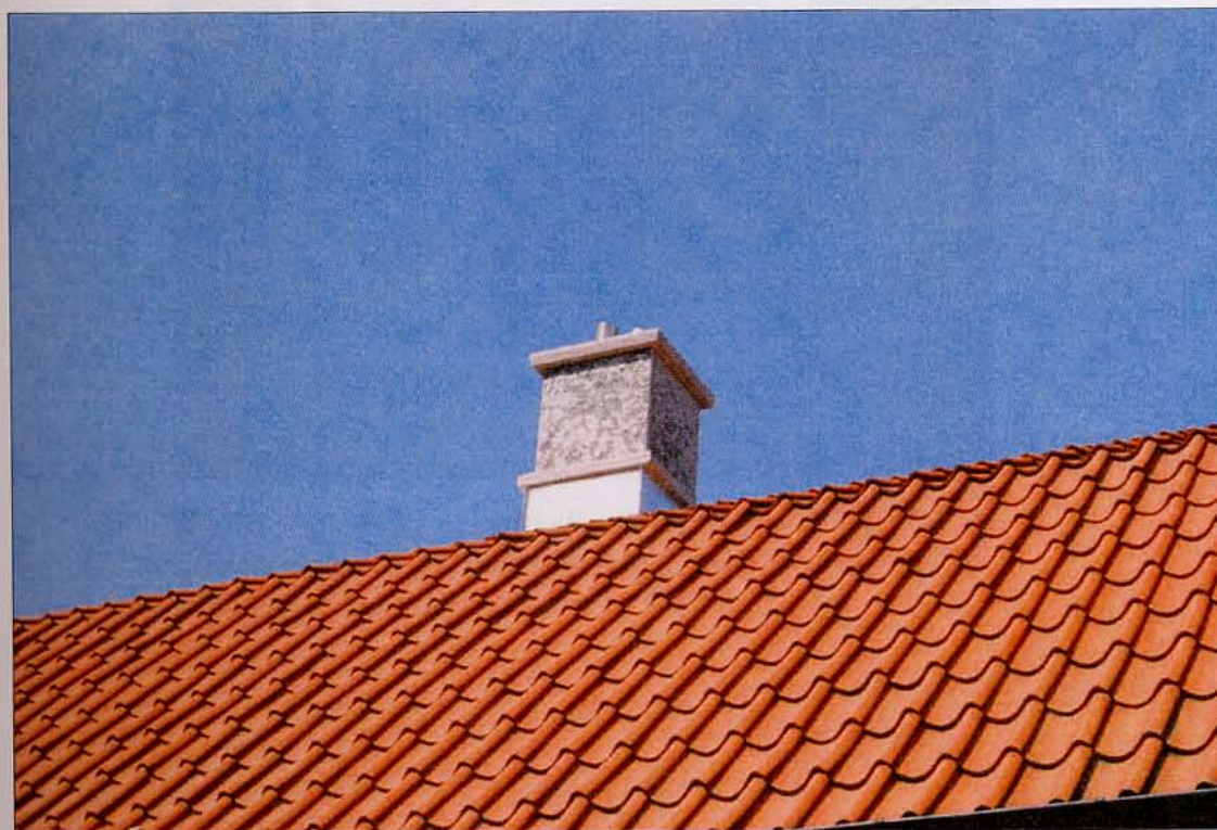
En av två nytillverkade hallaskorstenar i kalksten, 2003-06-17. Neg. nr 03/334:30.
