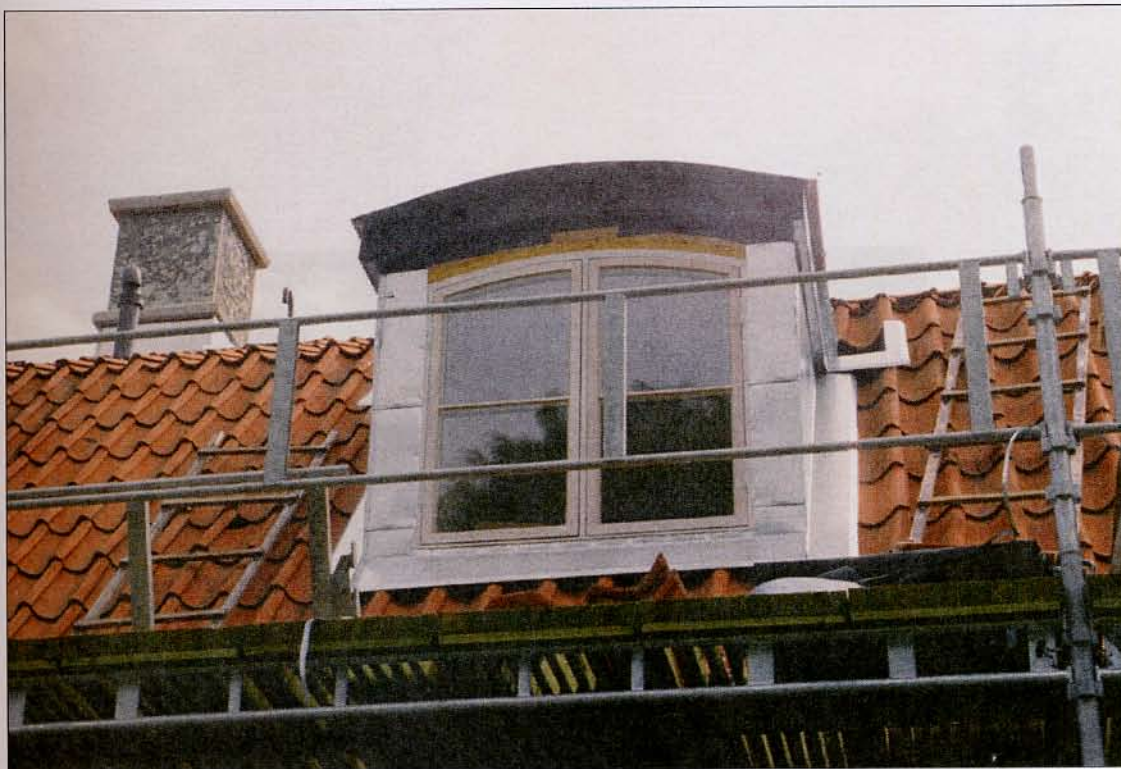
Takkupan under färdigställande, 2003-07-11. Notera plåtarbetet där plåtslagaren använder så små plåtar som möjligt. Fönsterbågen är nytillverkad med byggnadens övriga bågar som förlaga. Neg. nr 03/342:12.
