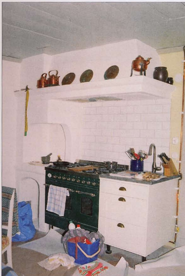
Kökets spisdal med plats för vedeldning till vänster i bild och nyuppförd murad spishuv, 2003-09-25. Neg. nr 03/362:11.
