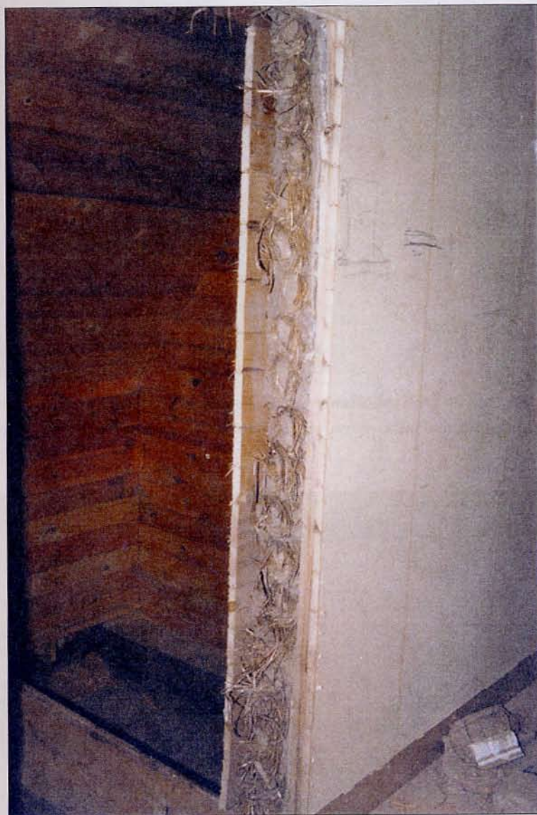
En av övervåningens innerväggar mellan sommarrum och garderob, 2002-11-07. De halm- och lerinvirade stockarna fungerar som isolering och hålls på plats av spåntade brädväggar. Neg. nr 03/2:9.
