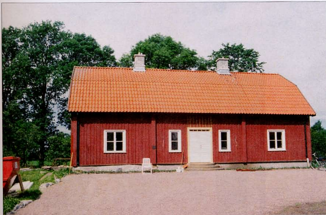
Huvudbyggnadens östfasad efter ombyggnaden, 2003-07-11. Här återstår målning av pardörrar och foder samt panel. Neg. nr 03/342:10.
