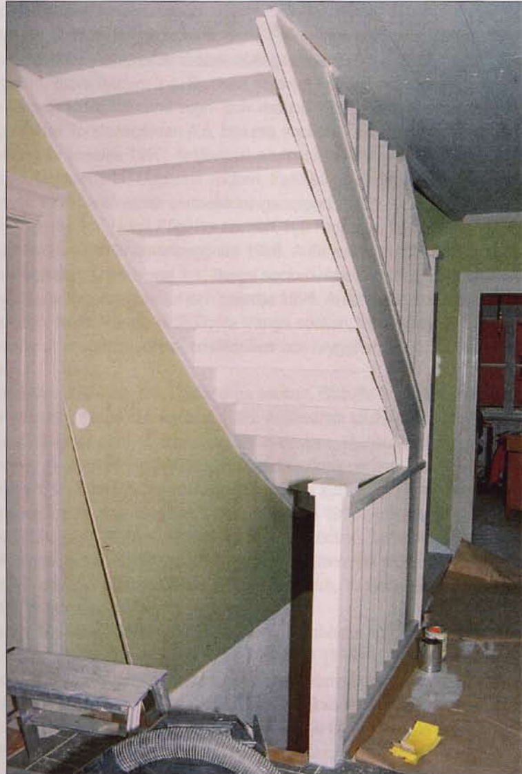
Förstugans trappa som byggts om från den tidigare stora "låda" som helt dominerade rummet. Räckets är nyttillverkat och resten av trappan är ombyggd. 2003-09-25. Neg. nr 03/362:12.
